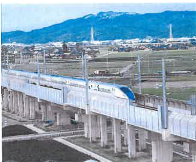
平成27年3月14(土)開業を目指し「W7系」試験走行 北陸新幹線建設 福岡地区 関連道水路工事(完工)
