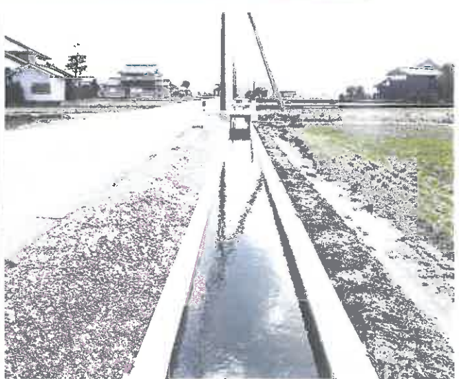
進む基盤整備促進事業「矢部地区」の用水路工事
