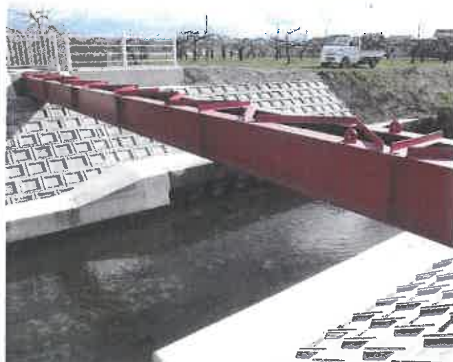
県営農業用河川工作物応急対策事業 「八口地区」 水路橋H27完工
