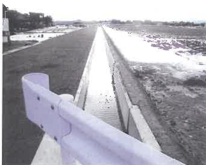
進む基盤整備促進事業「土屋・鳥倉地区」の用水路工事
