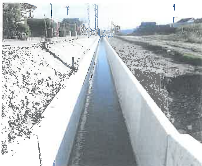
進む農地整備事業「土屋・鳥倉地区」の地区外排水路工事
