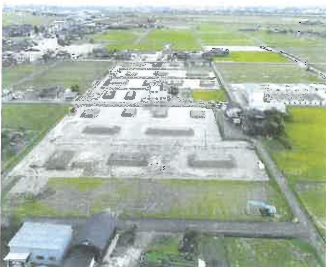
進む農地整備事業「石堤地区」
