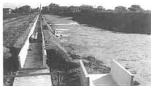
進心江尻地区ほ場整備工事（江尻地内）
