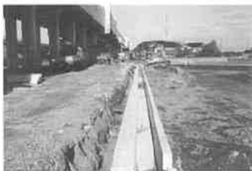
進心北陸新幹線建設関連排水路工事（山王地内）
