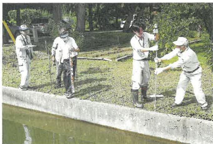
秋の農業用水路危険箇所一斉点検
