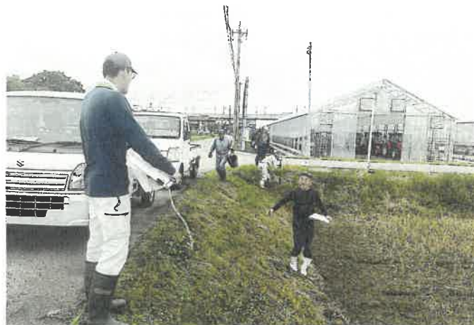
確定測量に係る境界杭設置作業(開ほつ地区)
