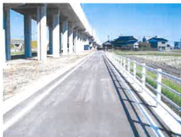
北陸新幹線建設福岡地区関連道水路工事 (開野地内)
