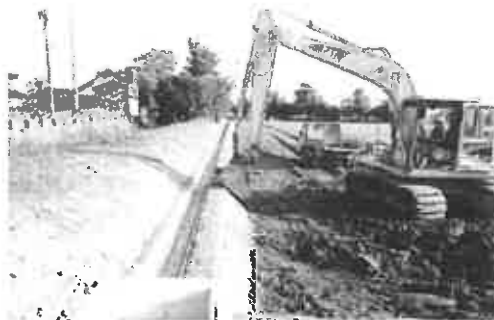
進む赤丸地区用排水路改修工事（赤丸地内）
